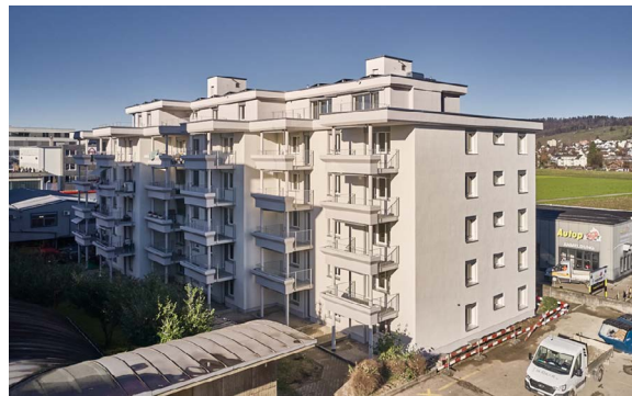
Aussenansicht nach Erneuerung
